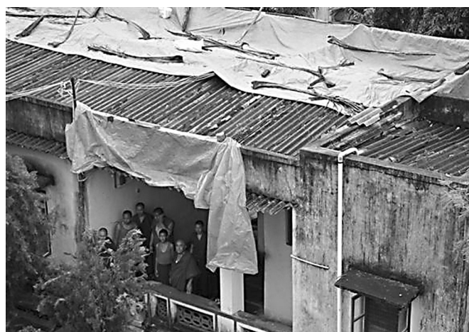
Hilfe für Mönche in Drepung gebraucht: Das Haus muss saniert und ausgebaut werden.
