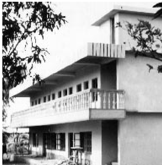
Für die Nonnen in Mundgod wurde eine Schule mit Küche und Speisesaal gebaut.
