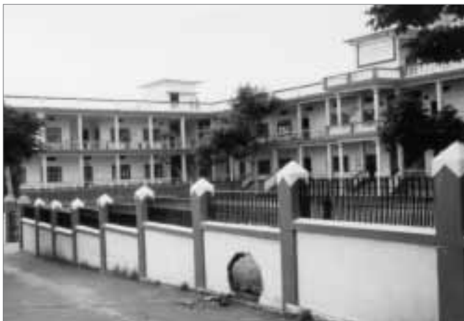
Neues Gebäude der Klosterschule in Sera
