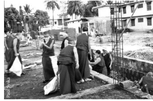
Nonnen beteiligen sich tatkräftig am Bau neuer Unterkünfte in Mundgod.
